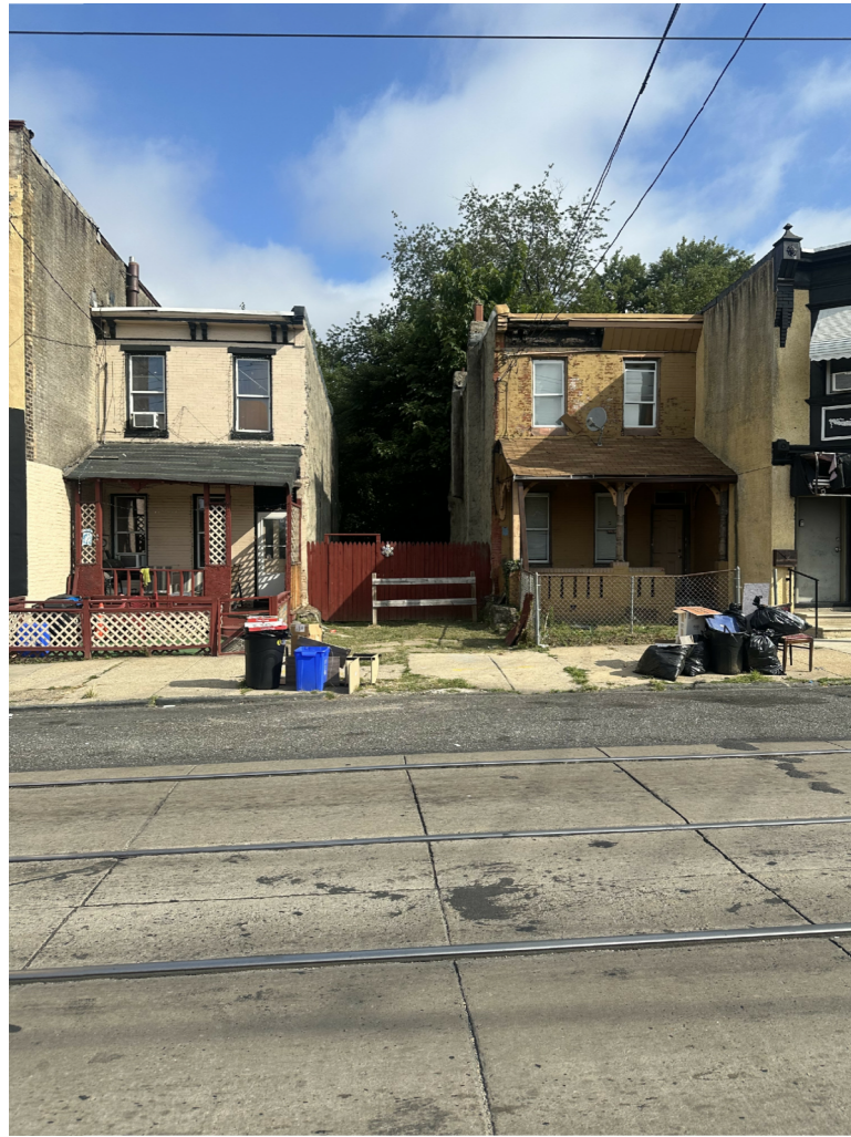
3 EXISTING CONDITIONS (FRONT) Z1.0 Scale: N.T.S.
