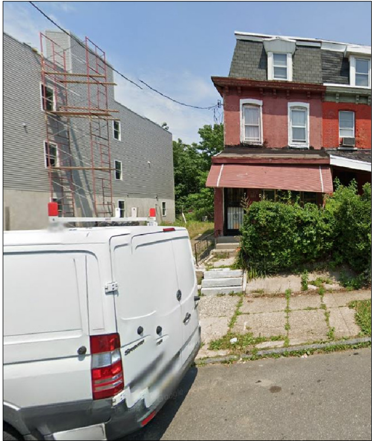
3 EXISTING CONDITIONS (FRONT) Scale: N.T.S.
