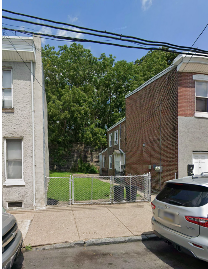
3 EXISTING CONDITIONS (FRONT) Z1.0 Scale: N.T.S.
